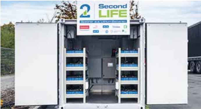
In SecondLife4Batteries wird der Einsatz von gebrauchten E-Auto-Batterien als stationäre Energiespeichersysteme entwickelt.
